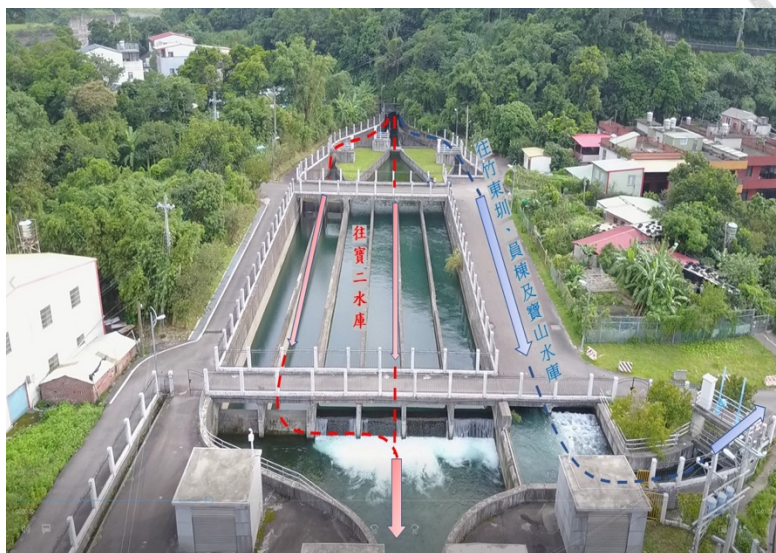
圖 12 上坪堰引水配置圖
