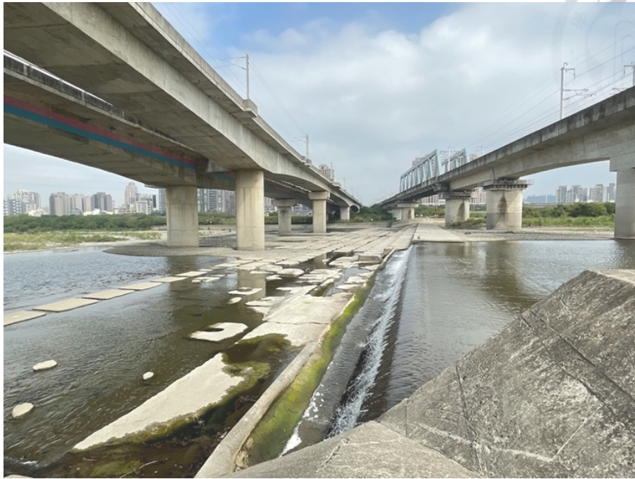
圖 9 隆恩堰的管柵式設計
