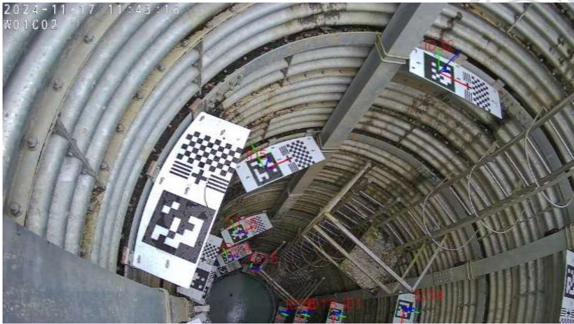
圖-78 智慧水井二號攝影機
