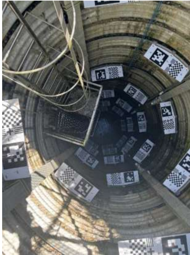
圖-76 集水井俯視
