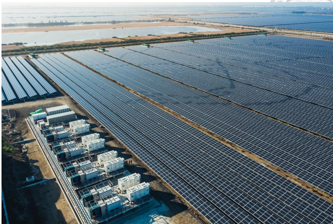
圖 6.2.2-2 台南鹽田太陽光電場的空照圖。
