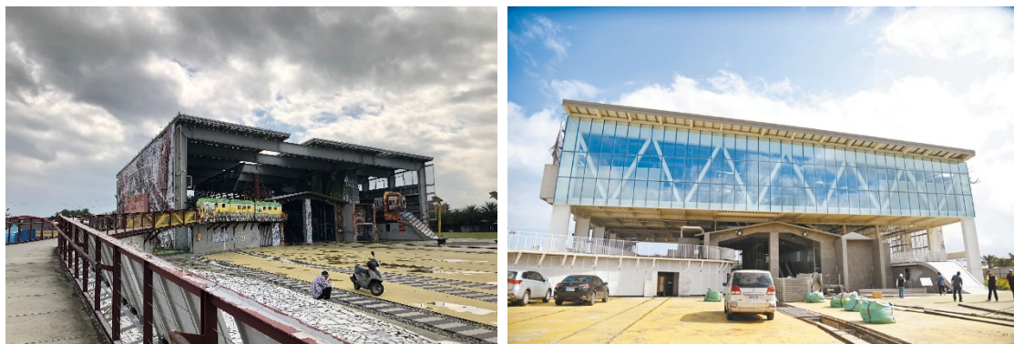
圖 2-10 陽光電城轉型前（2020）與轉型工程現況（2024）
