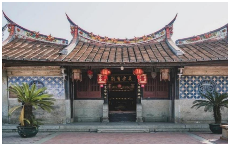
圖 5-3 修繕後的祠堂正立面
