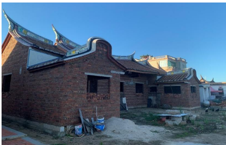
圖 5-41 2022 年 7 月埭美新厝區裡正在建造中的住宅
