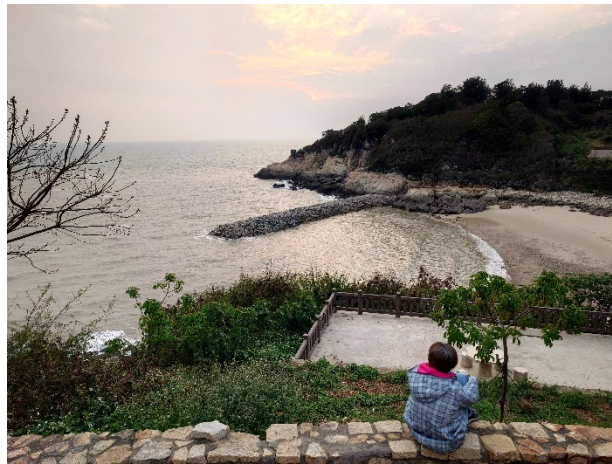
圖 64 為抵擋颱風長浪建造的津沙海堤
