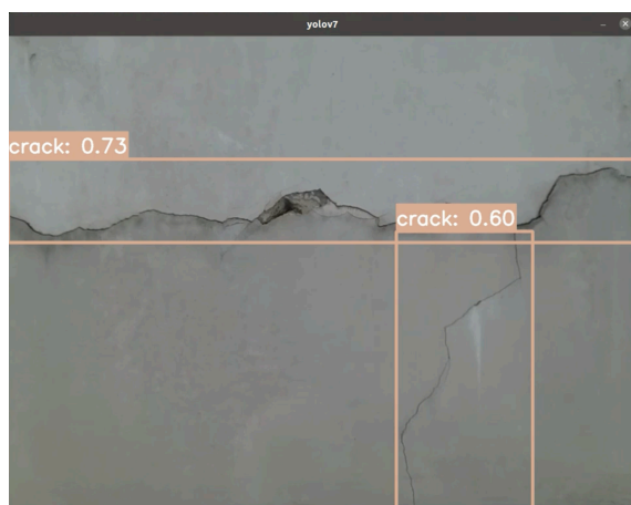
圖 4.19: 建物裂縫辨識結果圖
