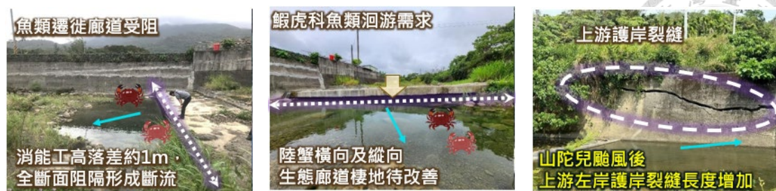
圖 3-5 泰安橋下游現況圖
