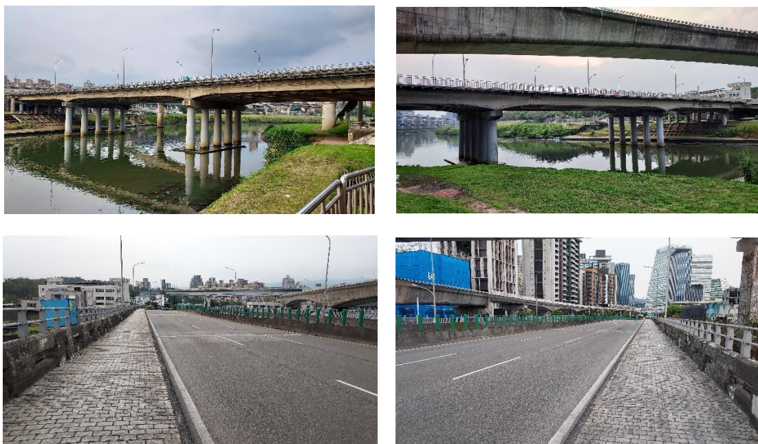
圖 4-18 南湖大橋現況照片(2024.03)
