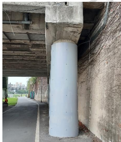
圖 5-4 橋墩鋼板包覆耐震補強
