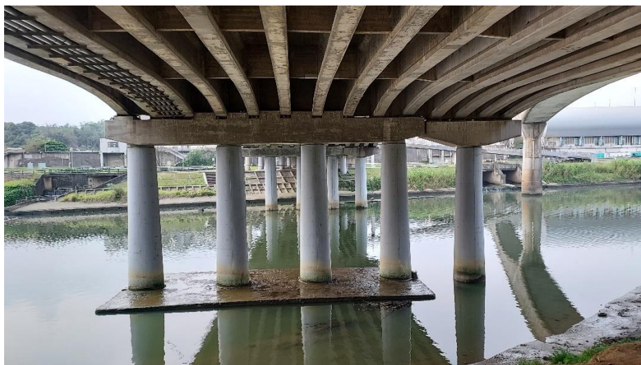
圖 5-12 南湖大橋橋墩現況(2024.03)
