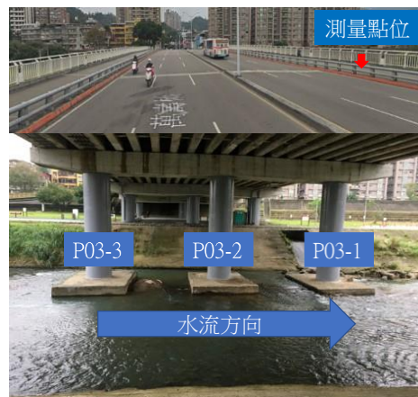
圖 4-11 萬壽橋測量儀器置放點位
