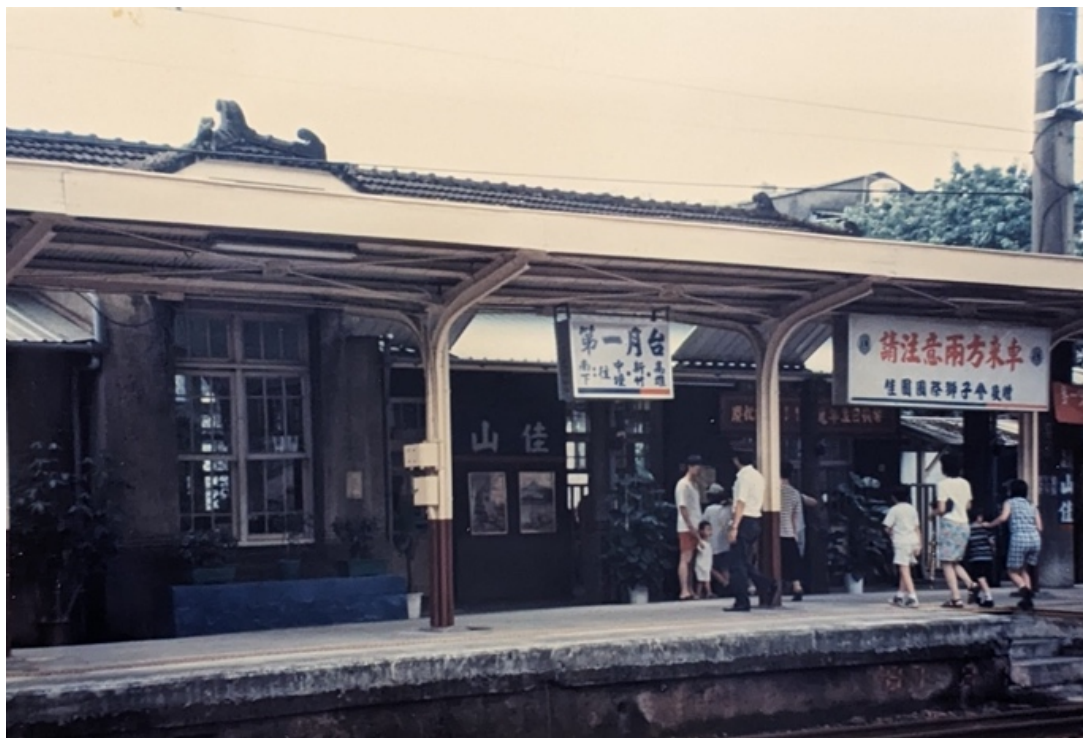
圖 3.1.5 新北市市定古蹟山佳車站 — 第一月台與站體修復前
