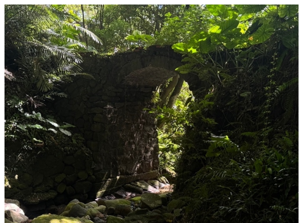
圖 4.2.2 石灰坑拱橋側面視角照
