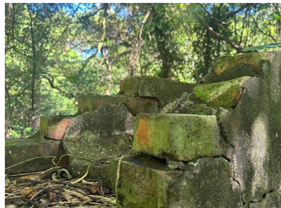
圖 2.2.26 山佳地區中和街煤炭規橋水渠道側視圖
