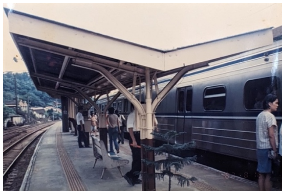
圖 3.1.8 山佳車站修復前月台老照片
