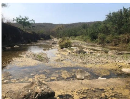
照片 7 固床工上游現況
