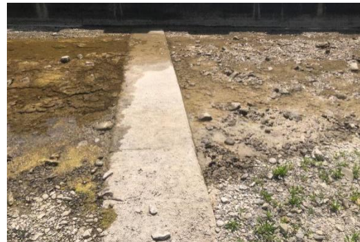
照片 16 固床工構造良好
