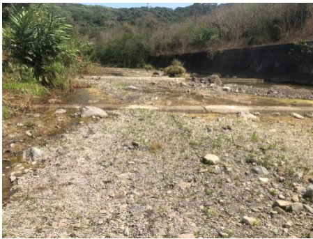
照片 11 固床工底床砂石
