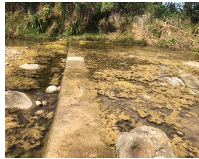
照片 4 固床工側面
