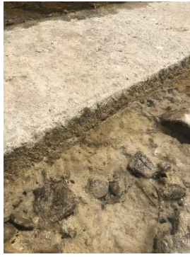
照片 9 固床工趾部
