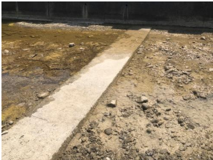
照片 13 固床工構造
