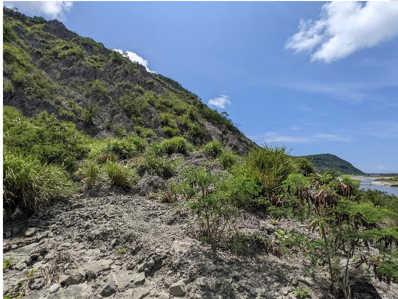
圖 6-17 利吉惡地河岸邊坡北段的道路被崩積物覆蓋形成土丘。(2022/06/22)
