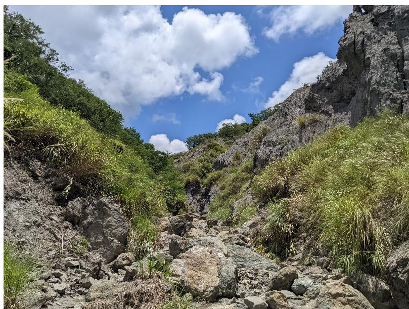
圖 6-21 支流河道，從下游向上游拍攝。左側邊坡被植被覆蓋，右側邊坡則較裸露。(2022/06/22)
