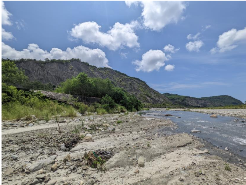
圖 6-28 利吉惡地邊坡平水期河床現況。拍攝位置為利吉大橋南側河岸。拍攝角度為向南，即往卑南溪下游方向拍攝。
