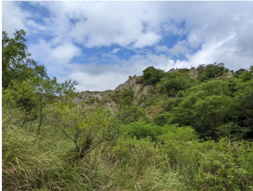
圖 6-11 利吉惡地內陸支流區域邊坡。被侵蝕的邊坡現今還是裸露。
