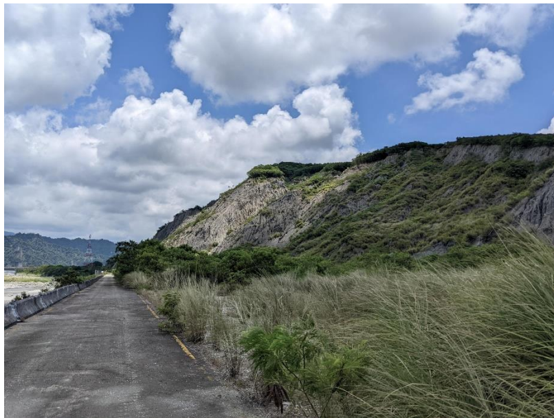
圖 6-15 利吉惡地河岸邊坡，照片於利吉堤防道路上有南向北拍攝。
