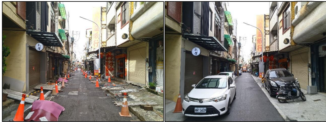
圖 3-15 米街徒步空間施工與完竣實景
