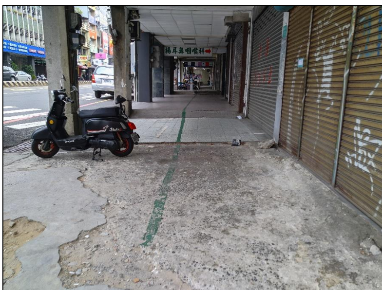
圖 3-23 有實施騎樓暢通，未實施順平與整平之實際案例
