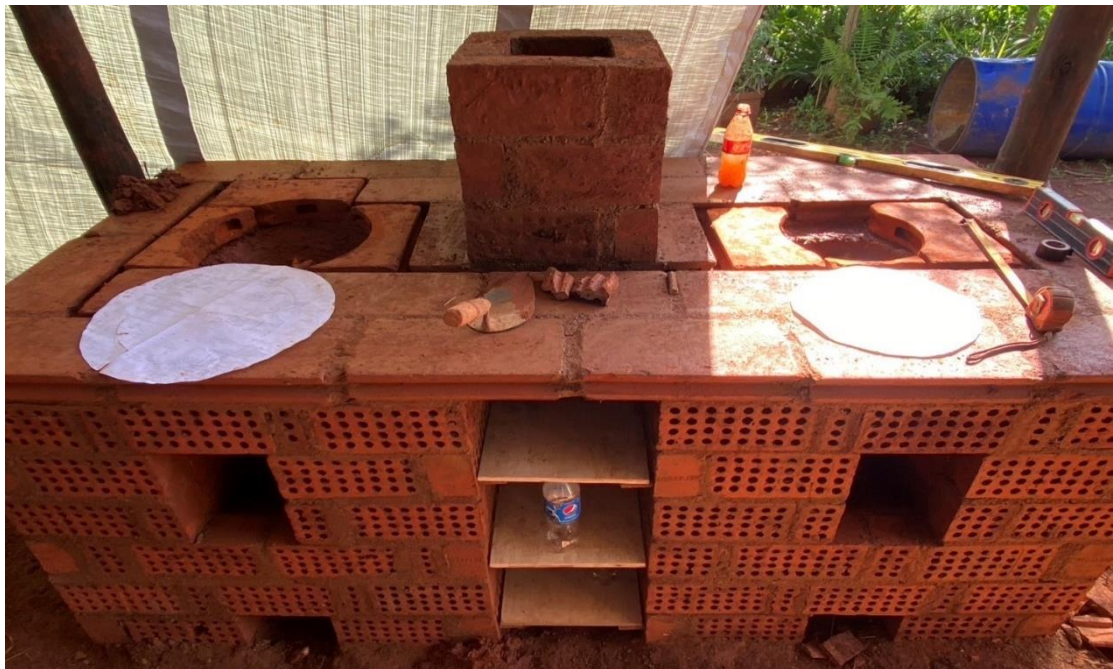
圖 35 紅磚爐灶具有更好的建置與燃燒效率
