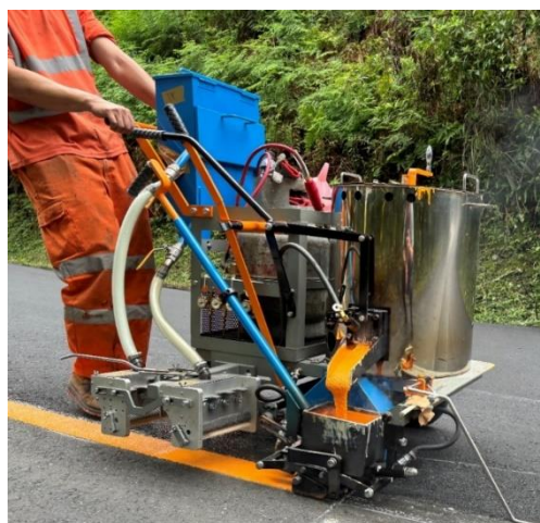
圖 3.8 滾軸式雙外撒劃線機
