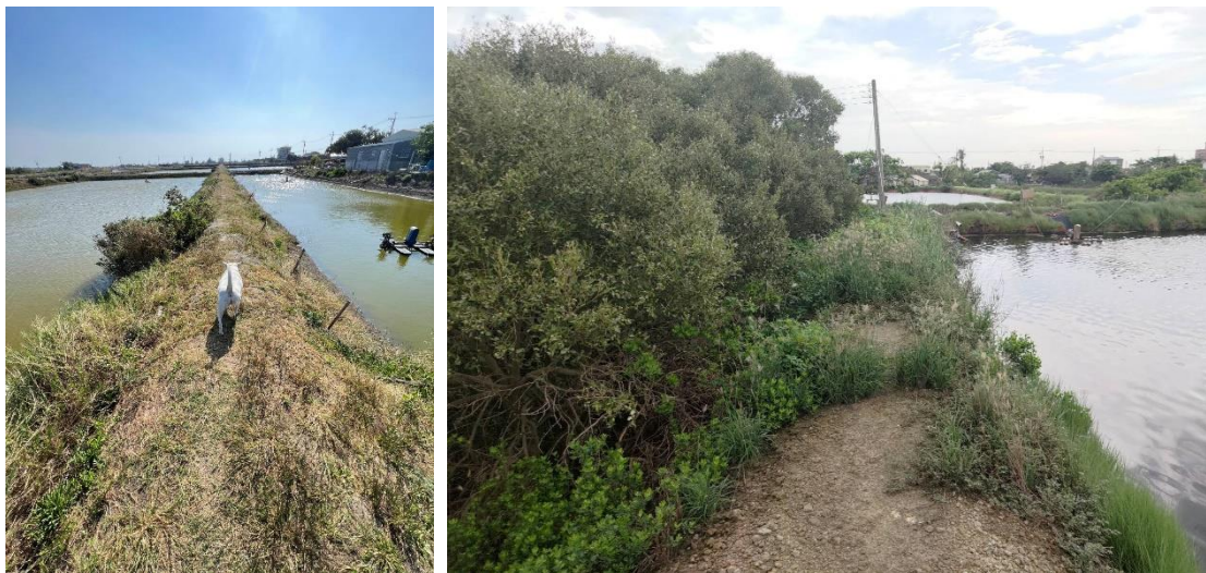
圖二十四、魚塭土堤（左）與魚塭混用紅磚的土堤（右）
