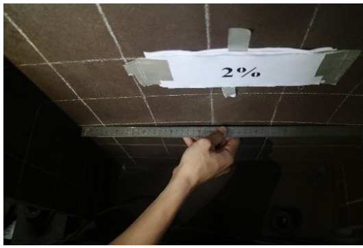
(a) 負 0.02 rad 柱底腹板局部挫屈
