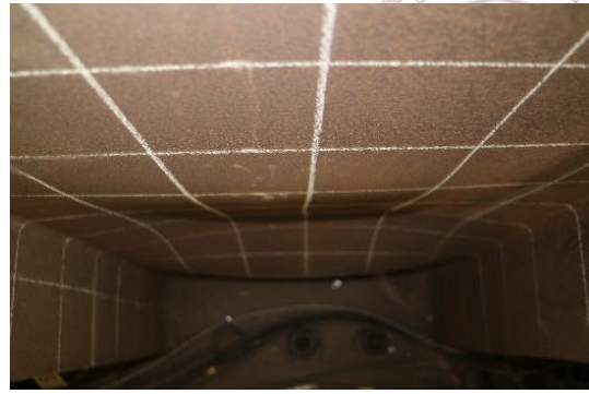
(b) 柱底腹板局部挫屈
