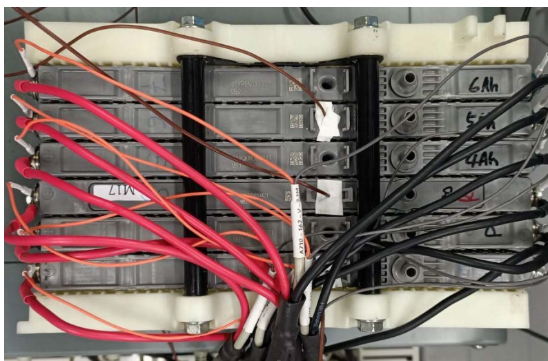
圖 3-8 高速老化實驗電池組
