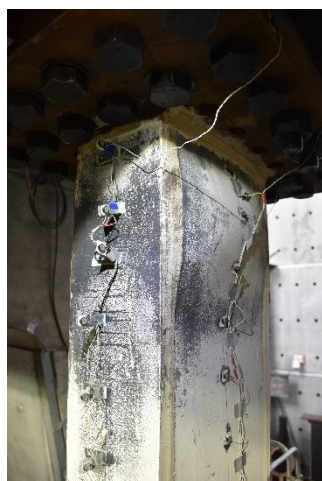
柱頂南面翼板、東面腹板
