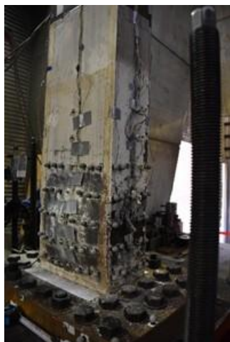
柱底北面翼板、東面腹板
