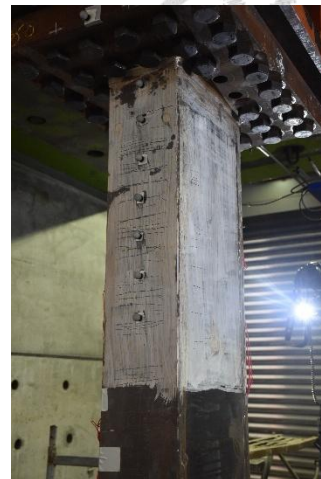
柱頂北面翼板、西面腹板
