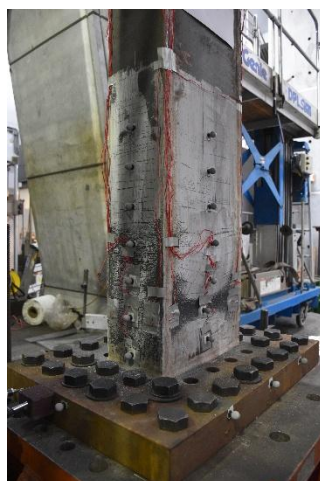
柱底南面翼板、西面腹板
