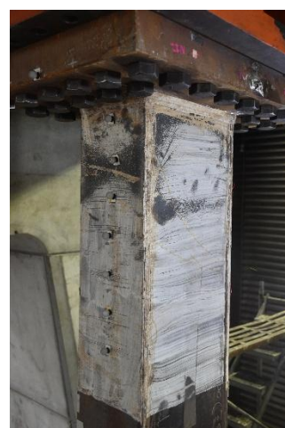
柱頂北面翼板、西面腹板
