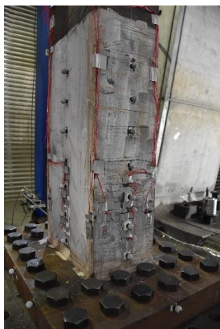
柱底北面翼板、東面腹板
