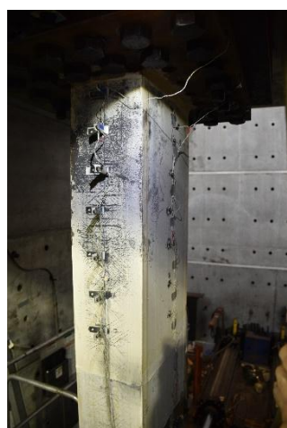
柱頂南面翼板、東面腹板
