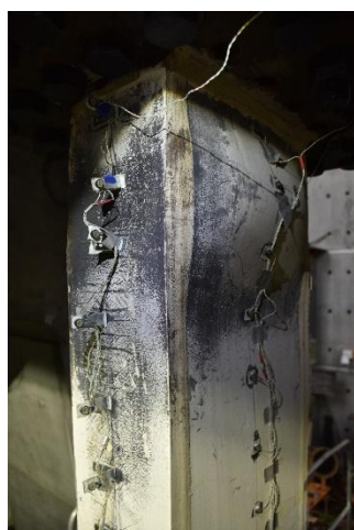
柱頂南面翼板、東面腹板
