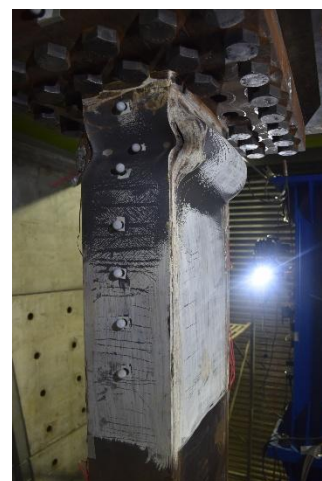
柱頂北面翼板、西面腹板
