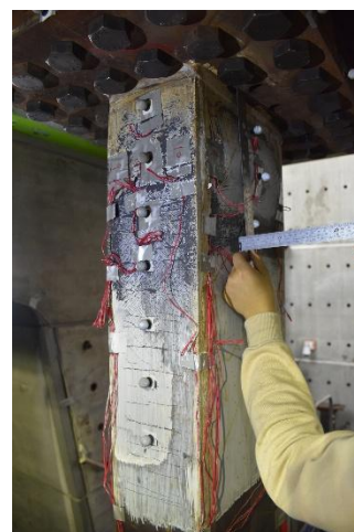
柱頂南面翼板、東面腹板
