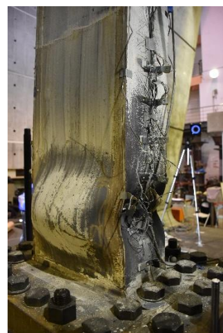
柱底南面翼板、西面腹板
