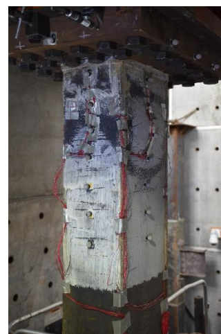
柱頂南面翼板、東面腹板
