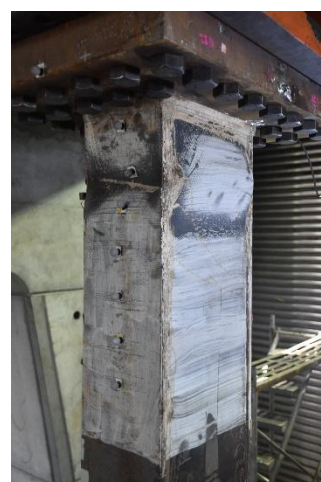
柱頂北面翼板、西面腹板
