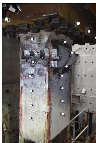
柱頂南面翼板、西面腹板
