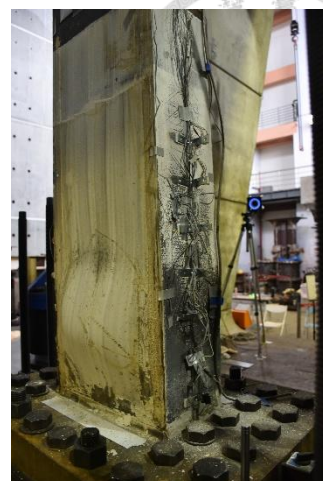
柱底南面翼板、西面腹板
