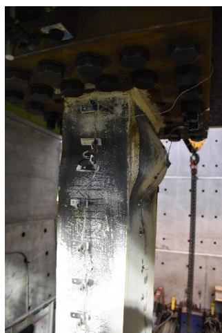
柱頂南面翼板、東面腹板
