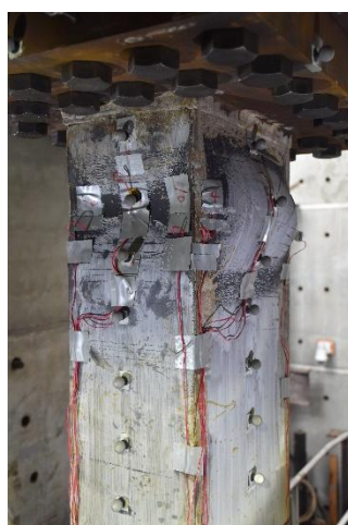
柱頂南面翼板、西面腹板
