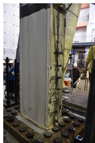
柱底南面翼板、西面腹板
