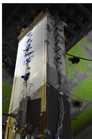
柱頂北面翼板、東面腹板
