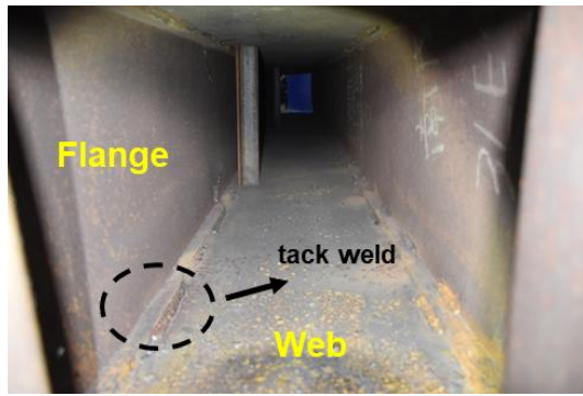
(a) 鋼柱內部
