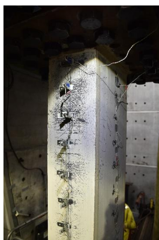
柱頂南面翼板、東面腹板
