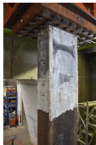
柱頂北面翼板、西面腹板
