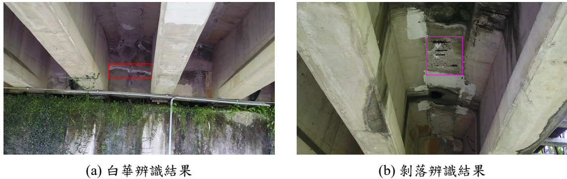
圖 4.20: 道南橋劣化辨識成果示意
