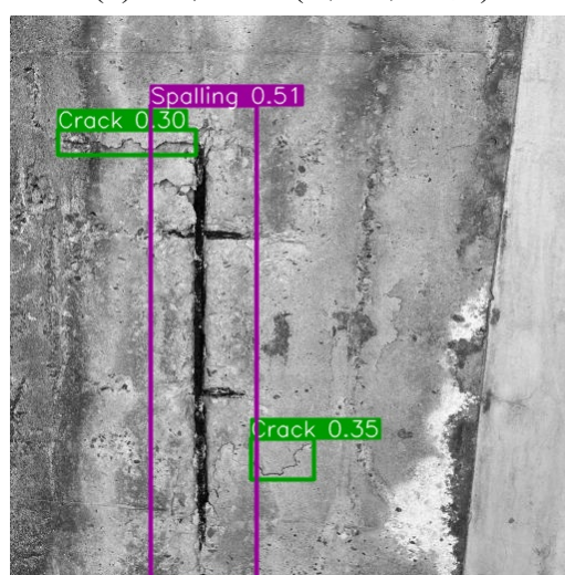
(d) 三類型劣化同時出現，部分漏檢 (攝於永福橋)
