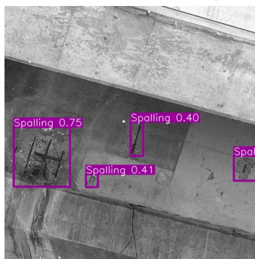
(d) 三類型劣化同時出現，部分漏檢 (攝於永福橋)
