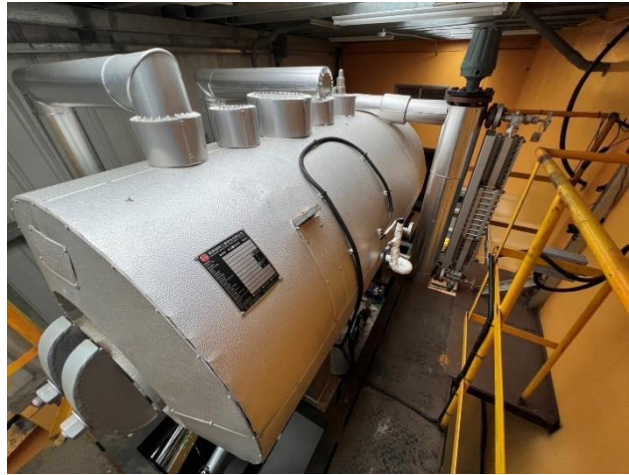
圖 3-2 臥式膨脹槽
