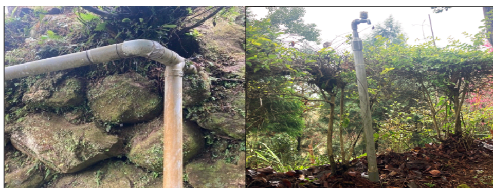
圖 13 地底鋪設水管線配送水資源
