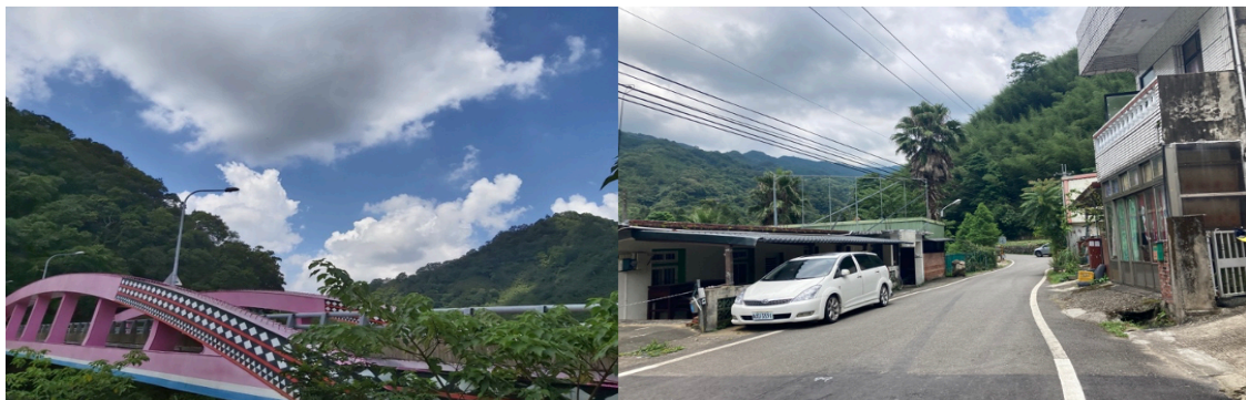
圖 7 部落南邊邊界—新樂大橋
