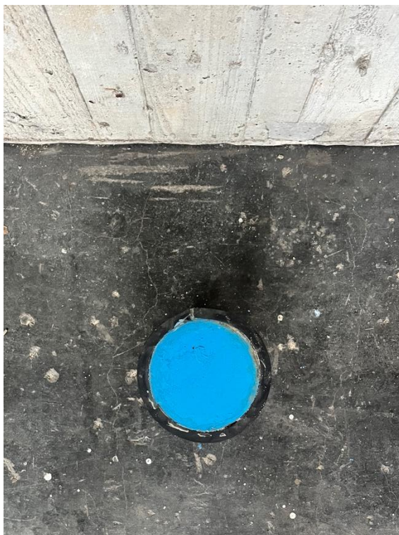
圖 5.14 混凝土圓柱與橡膠接合與最終固定完成俯視圖
