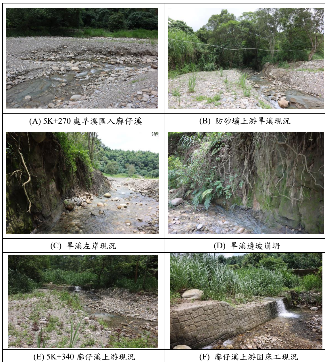
圖 3-3 旱溪分區現況調查照片
