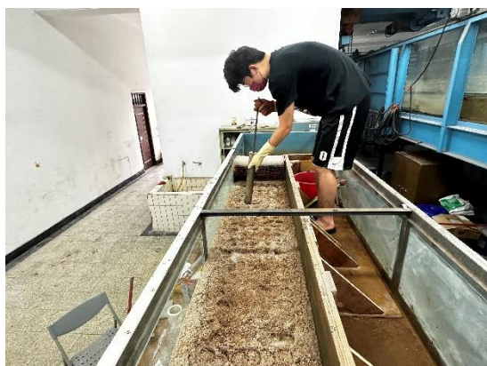
(A) 試驗渠道進行夯實上半部份
