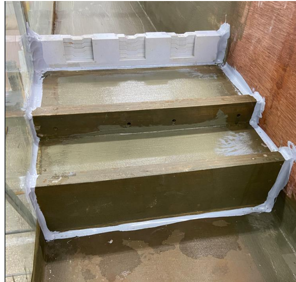
(C) 本試驗第一、第二固床工(實驗渠道)
