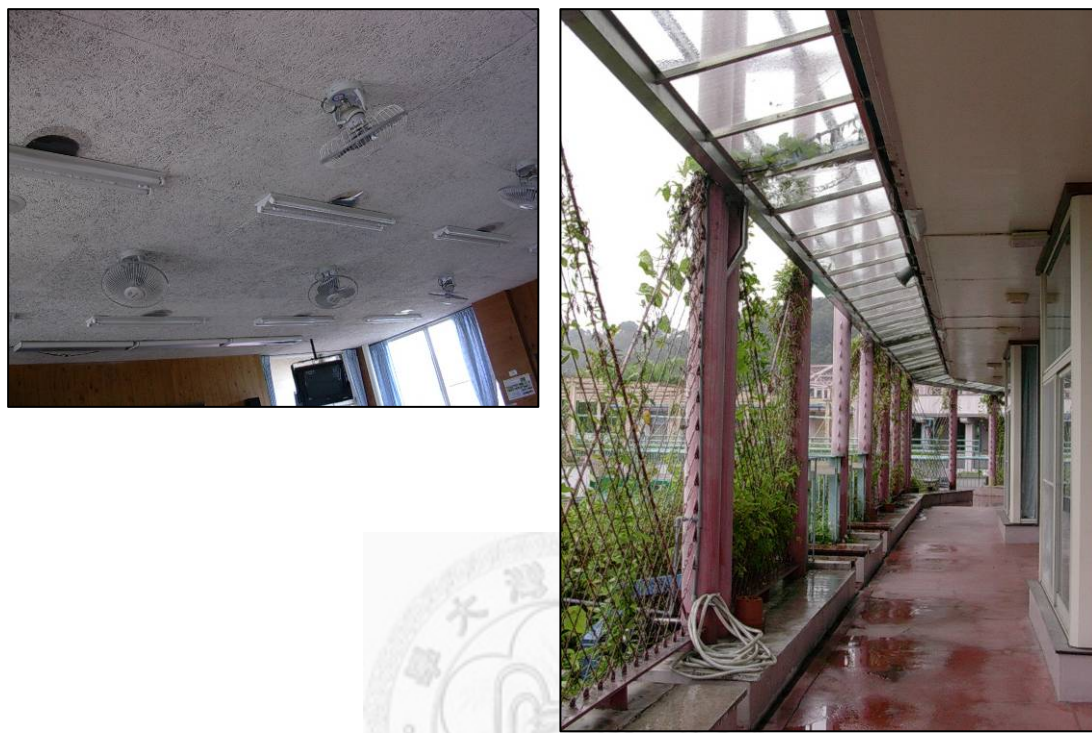
圖 3-11 原設計造成學校困擾的案例，左，原節能燈泡（天花空洞處）因維修費高而換裝一般燈管；右，簷深不足因此加裝透明遮版，但下雨時仍滲水。走廊旁的爬藤則不易生長。
