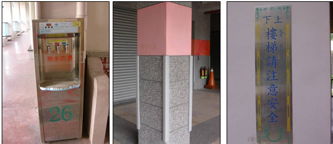
圖 3-9 學校建築常見安全措施：飲水器防燙透明遮板（左）；立柱防護設施（中）；校園常見的警語告示牌（右）。
