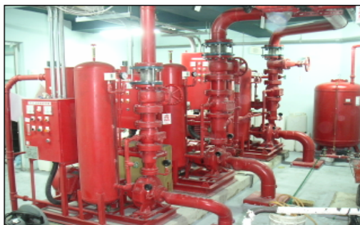
圖 -19 消防泵浦系統
