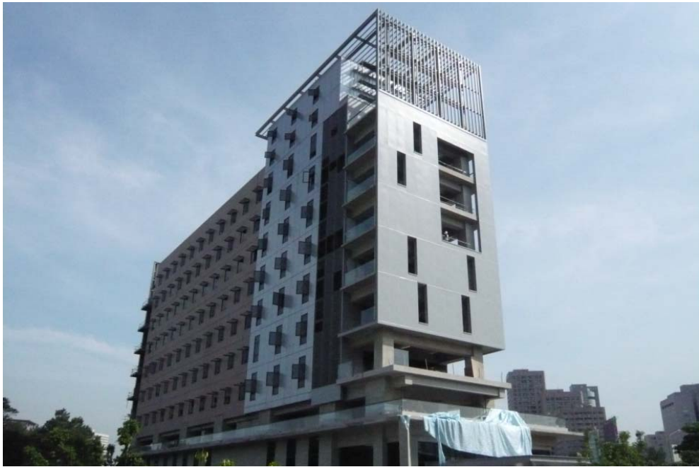
照片 2.3.1 台灣大學興建中之土木系研究大樓
