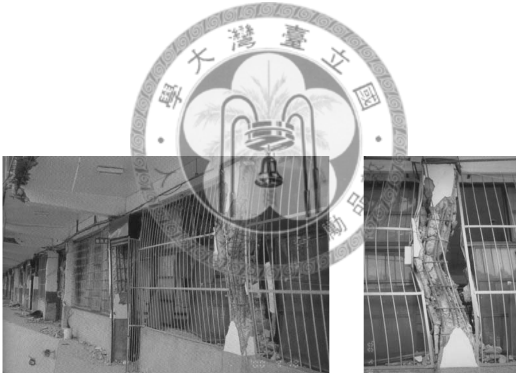
圖 2.7 窗台柱破壞
