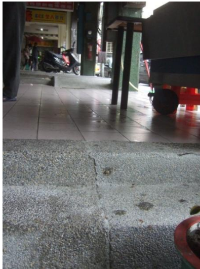
圖 5-7 騎樓常有階梯
