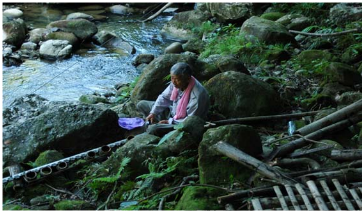
社員吳昌正在拆舊竹橋
