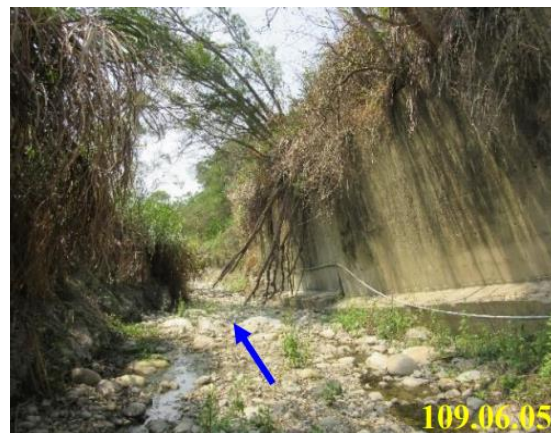
(B) 4K+200 右岸擋土牆傾倒
