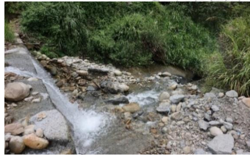
(H)壩體下游第二支固床工 (5K+065 固床工)
