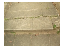
圖 4-24-8 鋪面龜裂不平
