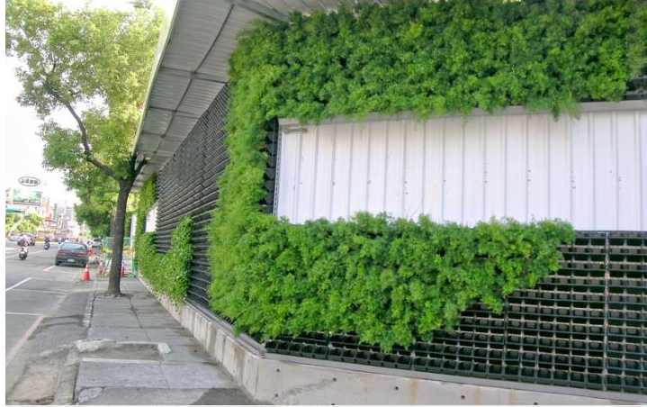
圖 2-3 工地模組化綠牆（圖片來源：三木景觀， http://www.3tree.url.tw/case_fence.html ）
