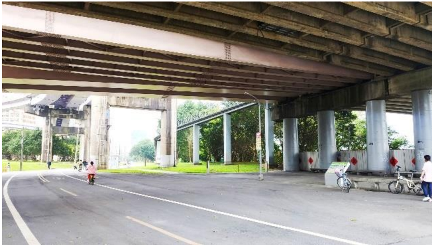
圖 5-1 福和橋下橋墩多已被鋼板包覆圖
