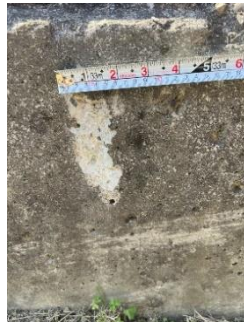
圖 5-2 使用直尺量測缺陷尺寸
