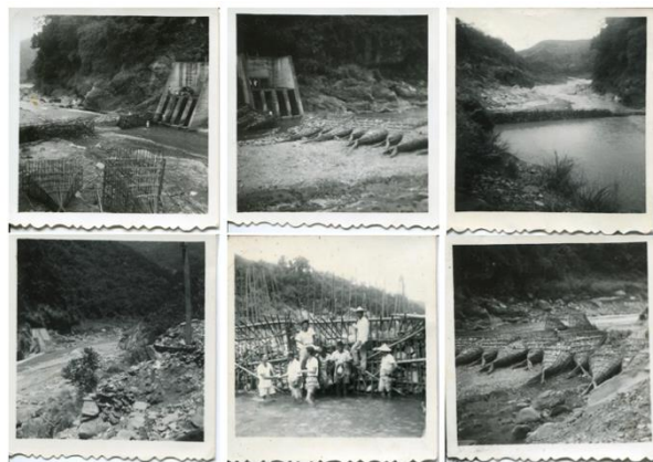
圖 3- 76 鹿野大圳工程施作
