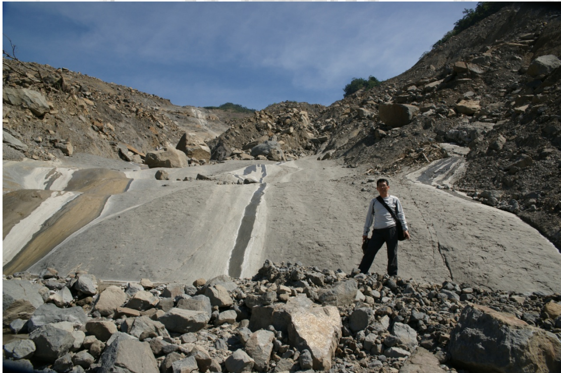
圖 5- 6：獻肚山崩塌區之堅硬岩盤，如此平滑及堅硬之岩盤自 509 高地前開始出現，往上直到崩塌源頭都陸陸續續可以見到。
