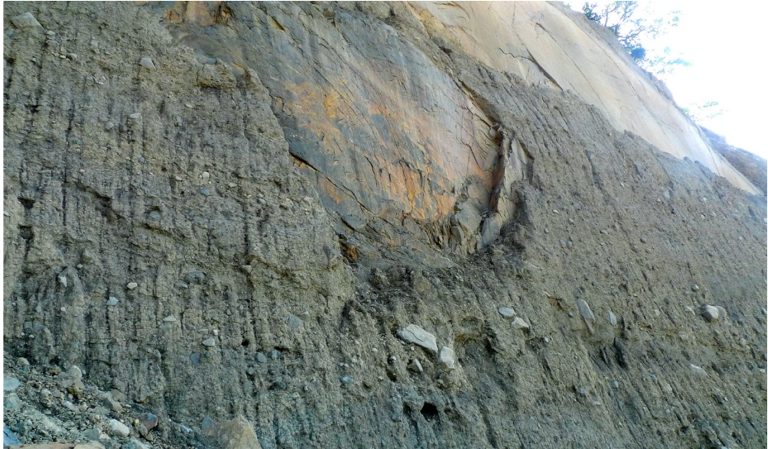
圖 5- 11：崩塌區南側在標高 850 公尺至 950 公尺之間有一近東西向平直的大峭壁，峭壁上有崩積物黏貼於上。
