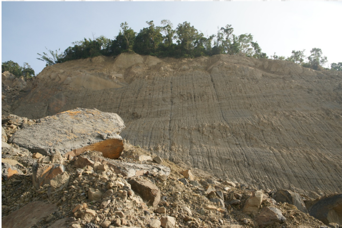
圖 5- 10：崩塌區源頭南側在標高 850 公尺至 950 公尺之間有一近東西向平直的大峭壁。
