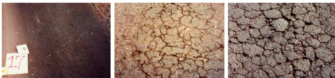
圖 2.1 鋪面龜裂嚴重程度示意(a)輕級(b)中級(c)重級 (內政部營建署，2002)
