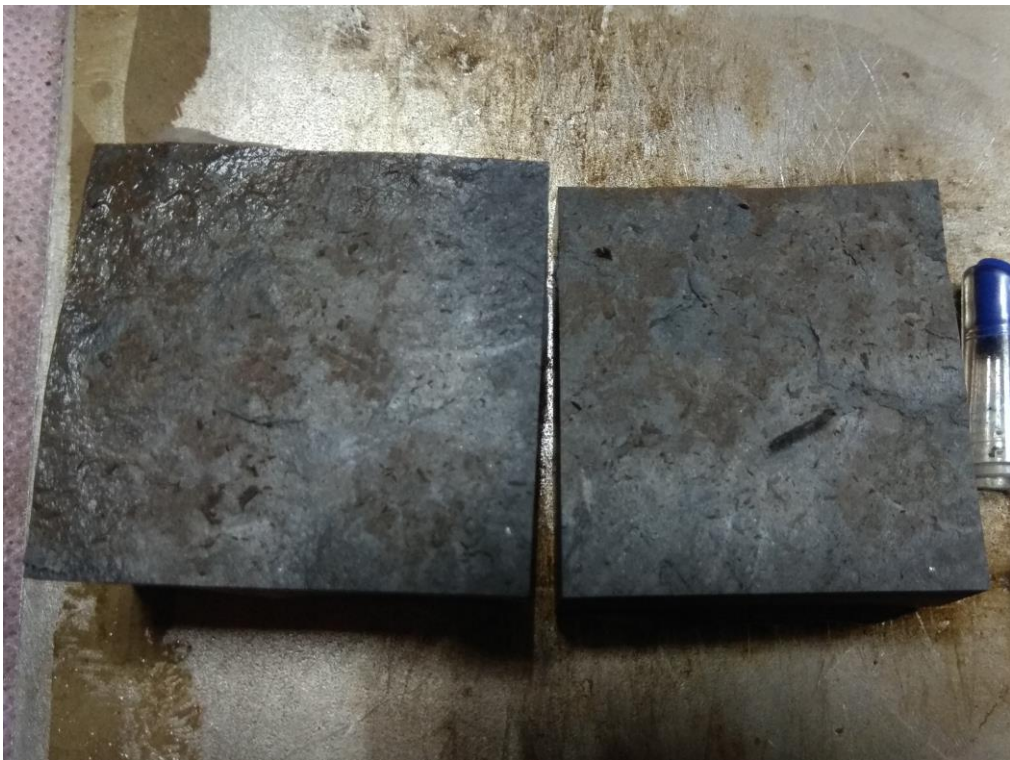
編號 TW3 試體破壞面之銹染情況：
