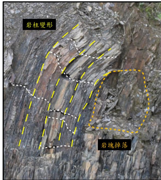
圖 6.13 現地邊坡局部放大圖
