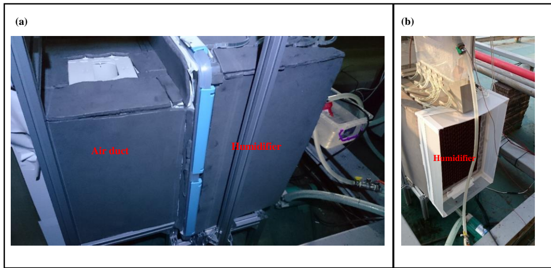
圖 2-05、加濕器熱散失防範措施。(a)絕熱層(灰色的部分)。(b)加濕器的風道。
