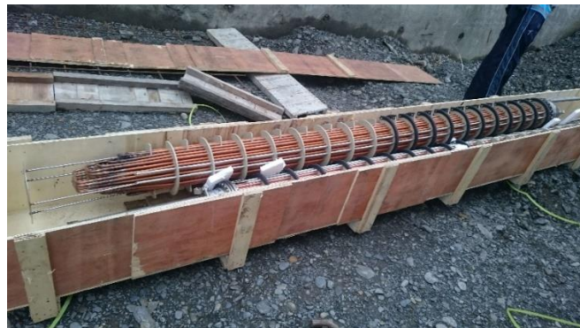
圖 3-6 多 U 型熱交換器
