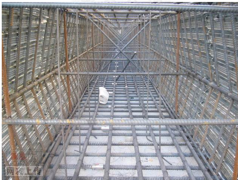
圖 2.3-2 基礎版後澆帶施工照片
