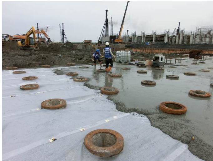
圖 3.3-24 標高器定高程刮平二次 PC 圖
