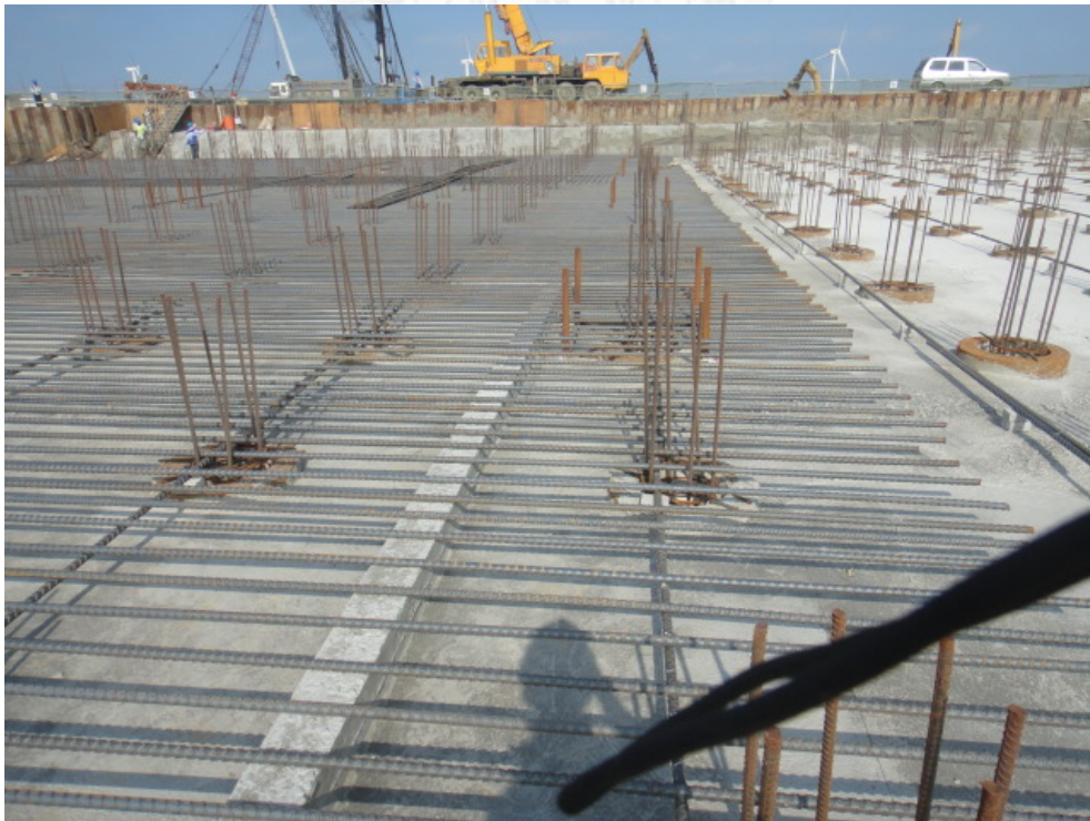
圖 3.3-22 底層鋼筋施工縫遮斷施工圖
