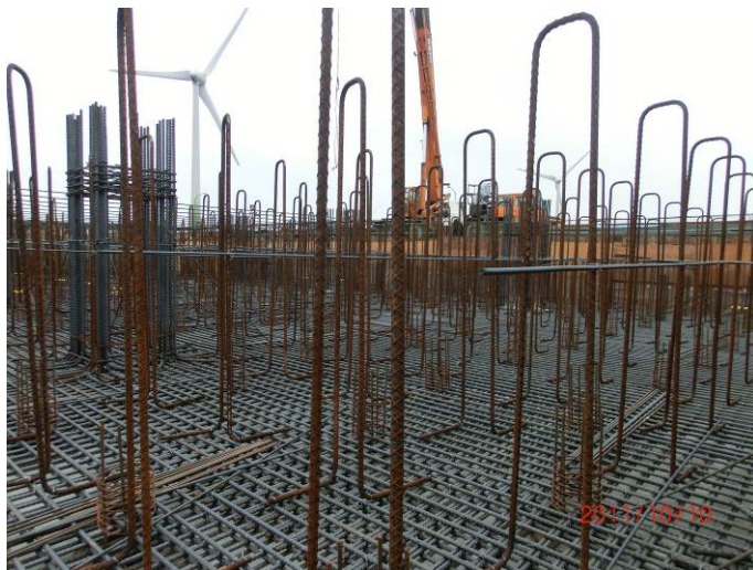
圖 3.3-26 上層筋工作筋綁紮圖
