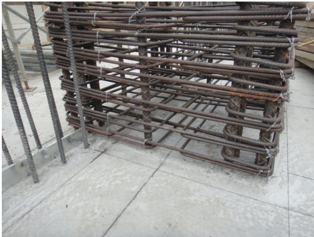
圖 3.3-33 混凝土澆置後柱箍筋綁紮
