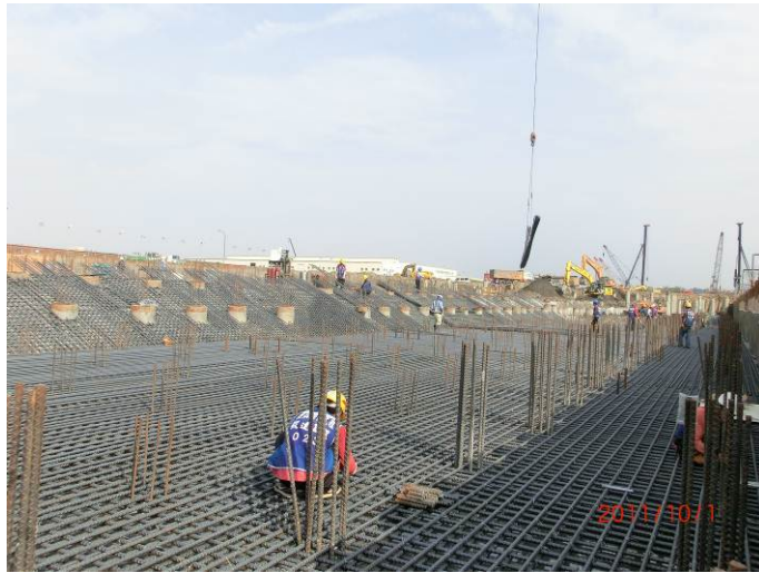
圖 3.3-25 底層筋綁紮圖
