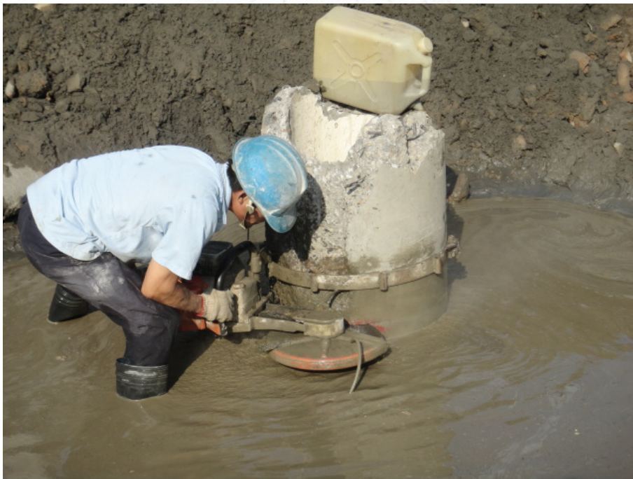
圖 3.1-7 斷樁切除施工圖
