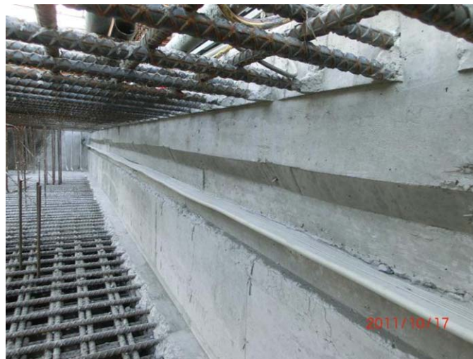
圖 3.3-13 施工縫止水帶施工圖
