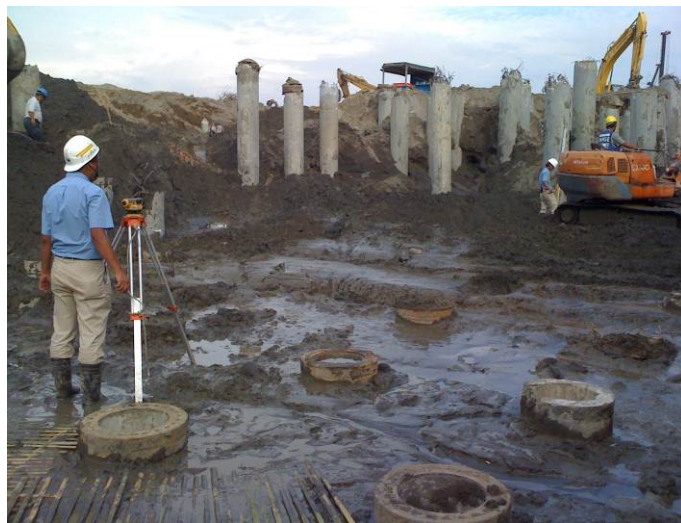
圖 3.3-23 土方開挖高程測量圖
