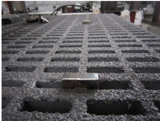
(c) 玻璃纖維橋面格柵板與複材梁連接狀況
