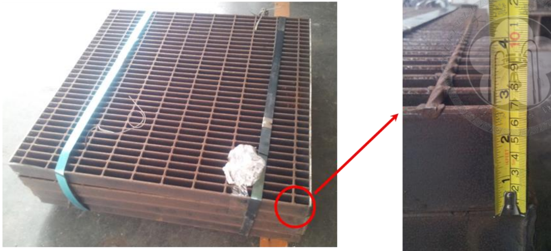
照片 2.1 鋼橋面格柵板
