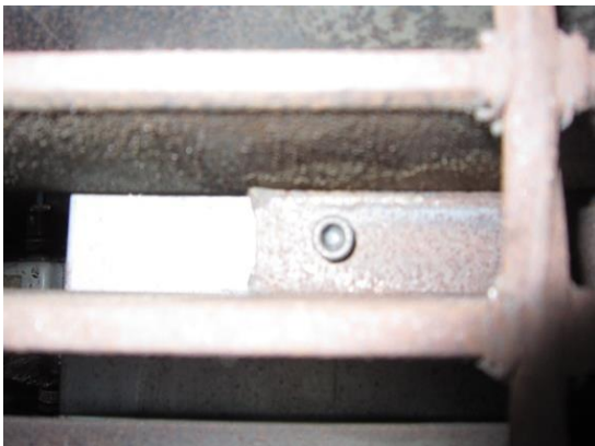
(c) 鋼格柵板與複材梁連接狀況
