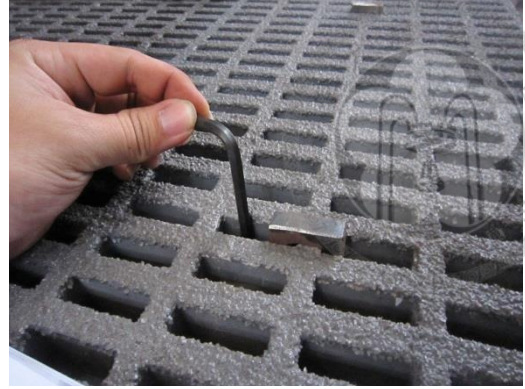
(b) 利用板手固定橋面板及腹材梁
