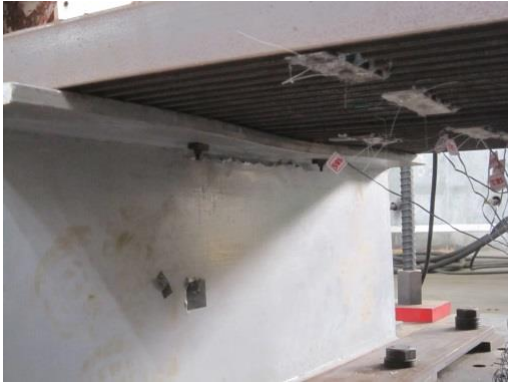
(a) 複材梁梁腹板交界處破壞 (345 kN)
