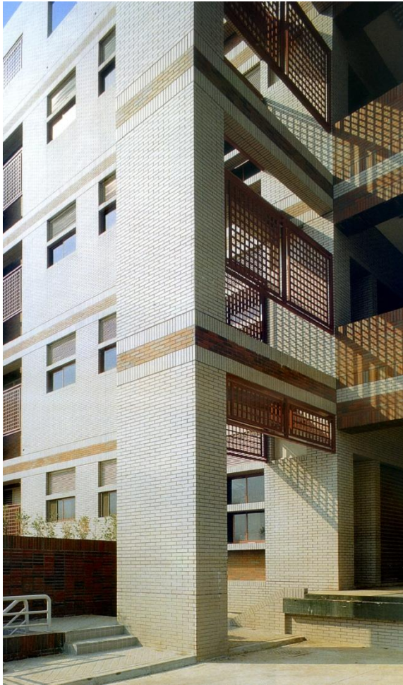
圖 23 南面戶外管道空間
