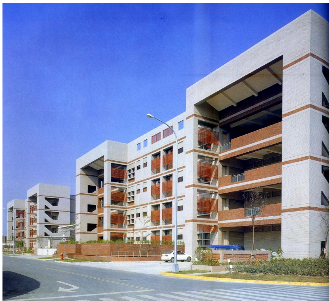
圖 22 標準廠房 A.B 廠房全景
