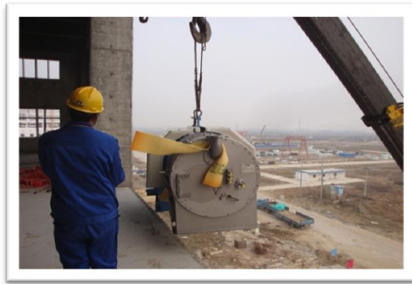
圖 1.3 運用吊具吊送機電設備
