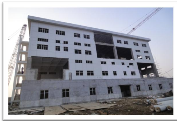
圖 1.4 建築物預留牆面待機電設備進場
