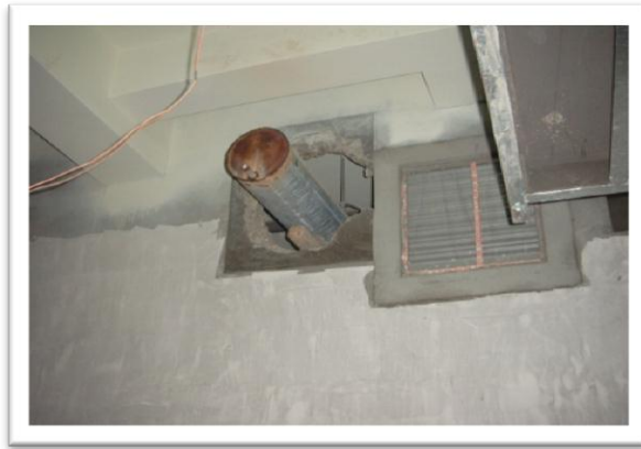
圖 1.5 未預留管線預留孔，牆面需重新鑽孔
