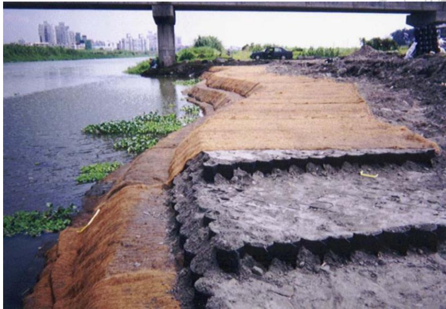
圖2.3 蜂巢格網應用於低水護岸整治(輔彬實業，宜蘭河整治)
