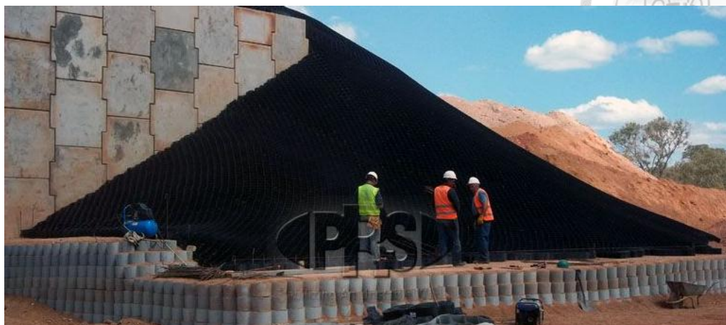
圖2.5 蜂巢格網堆疊式加勁擋土牆(摘自PRS公司網站)
