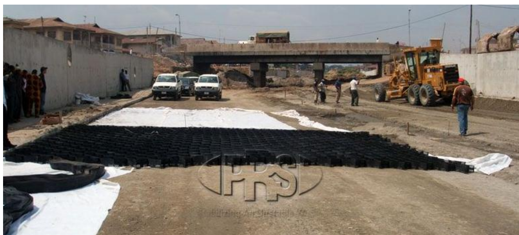
圖2.4 蜂巢格網應用於溝渠引道保護(摘自PRS公司網站)
