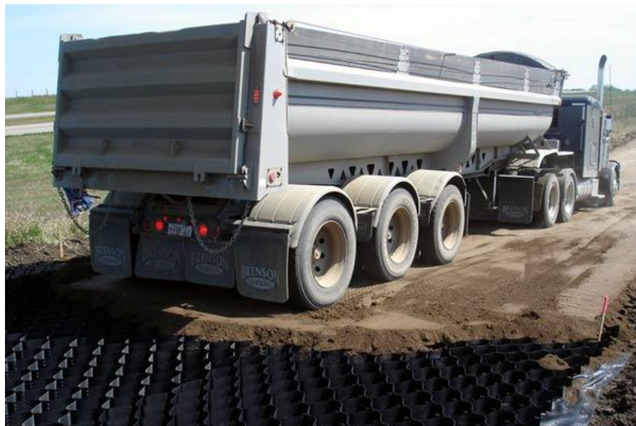
圖2.2 蜂巢格網應用於軟弱地盤加勁(摘自Presto公司網站)
