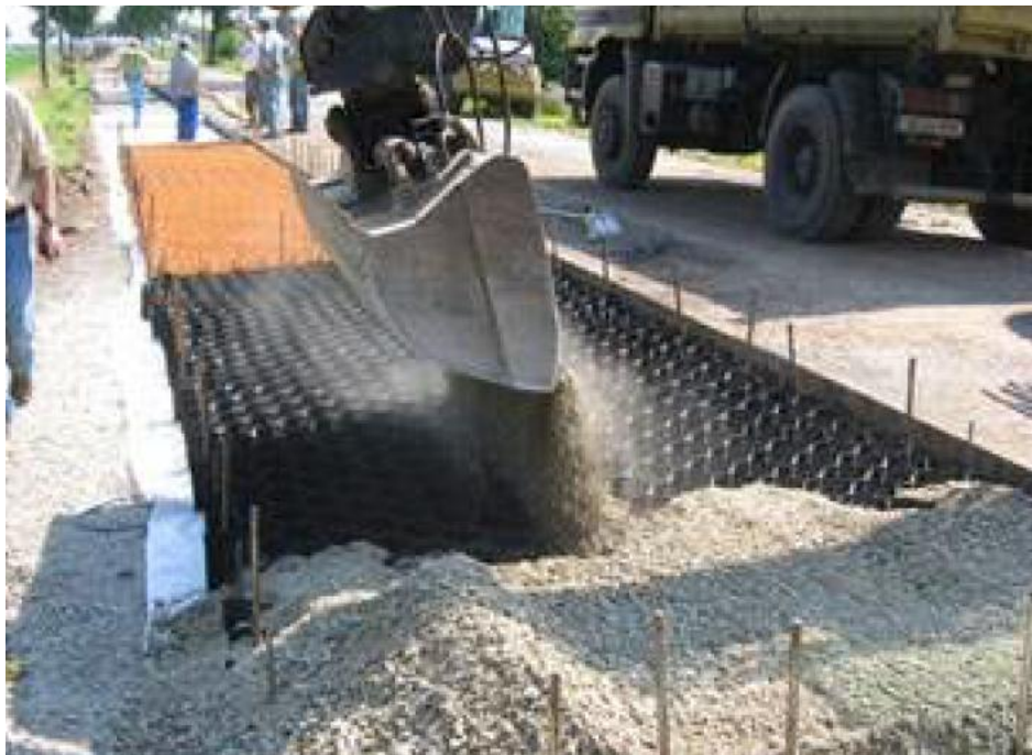
圖2.22 現地試驗施作照片 (Meyer and Emersleben, 2009)
