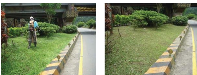
圖 4-8、案例一機械割草作業照片
