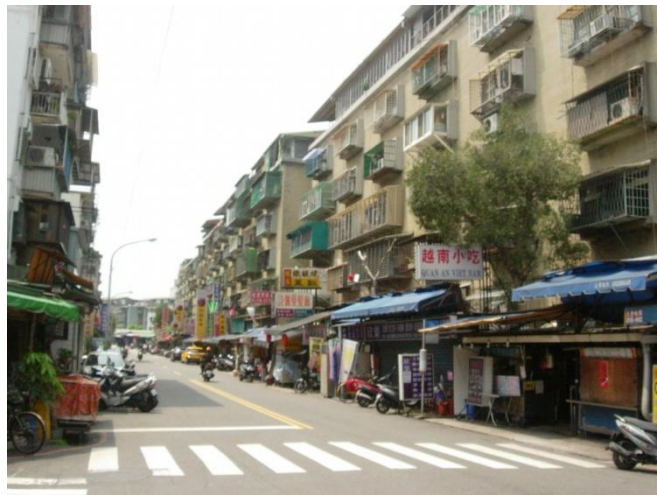
圖 5-8 劍潭一期整宅 B 棟沿街店家及攤商現況
