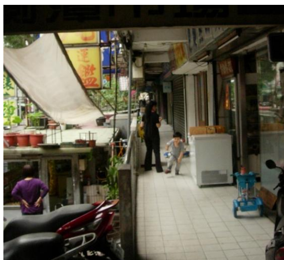
圖 4-9 劍潭二期整宅一樓通廊
