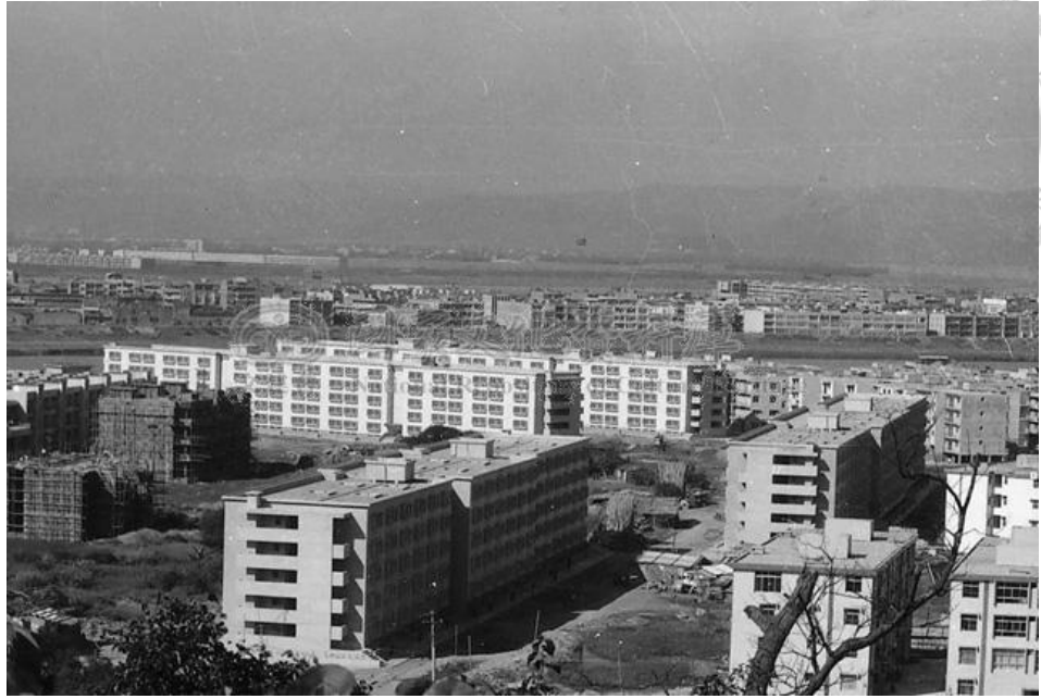
圖 4-4 劍潭一期整宅 984 戶竣工照
