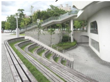
樓梯及階梯廣場
