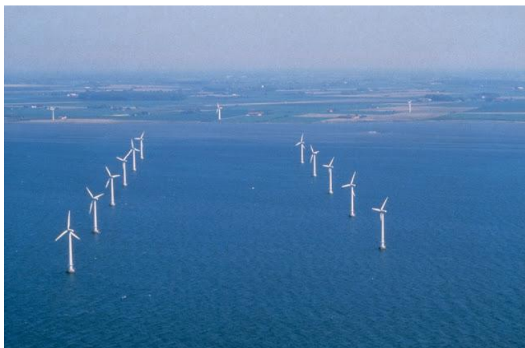
圖 1-4 丹麥 Vindeby 離岸風場[4]
