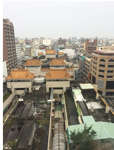
圖 3-3-6：俯瞰拆除前的中國城 資料來源：自行拍攝
